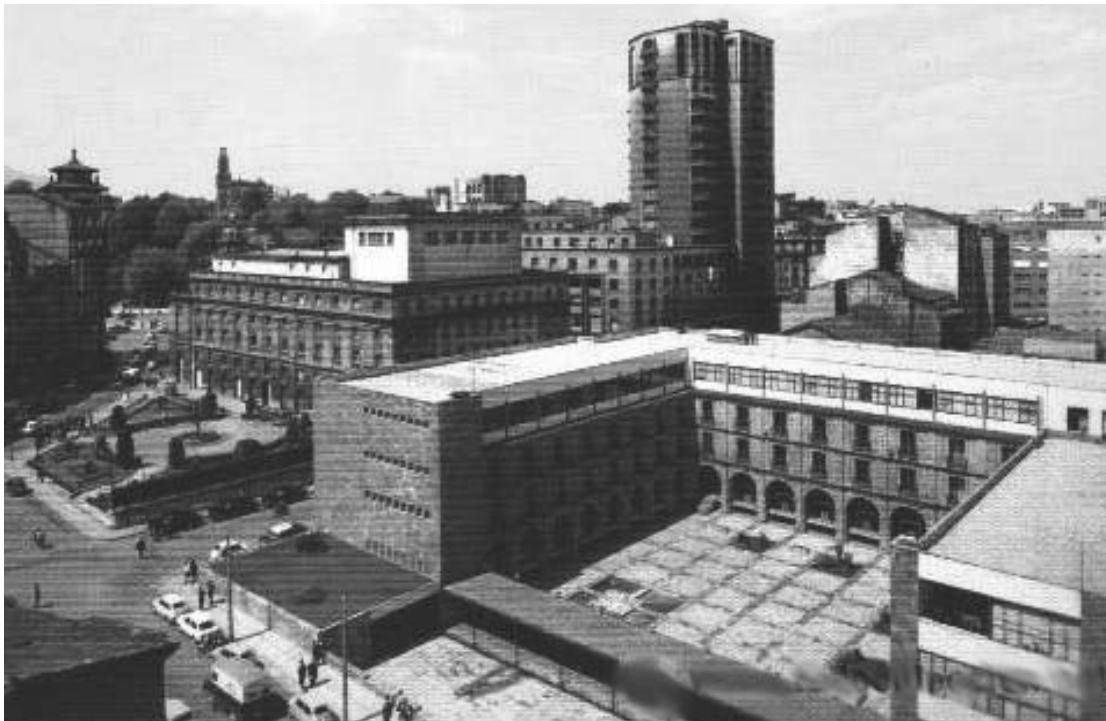
Fig. 12. El transformado edificio de Santa Clara continuó ejerciendo su representatividad en un ámbito cada vez más integrado con la nueva centralidad urbana ( http://www.skyscrapercity.com/showthread.php?t=458551 [4 de junio de 2011]).
