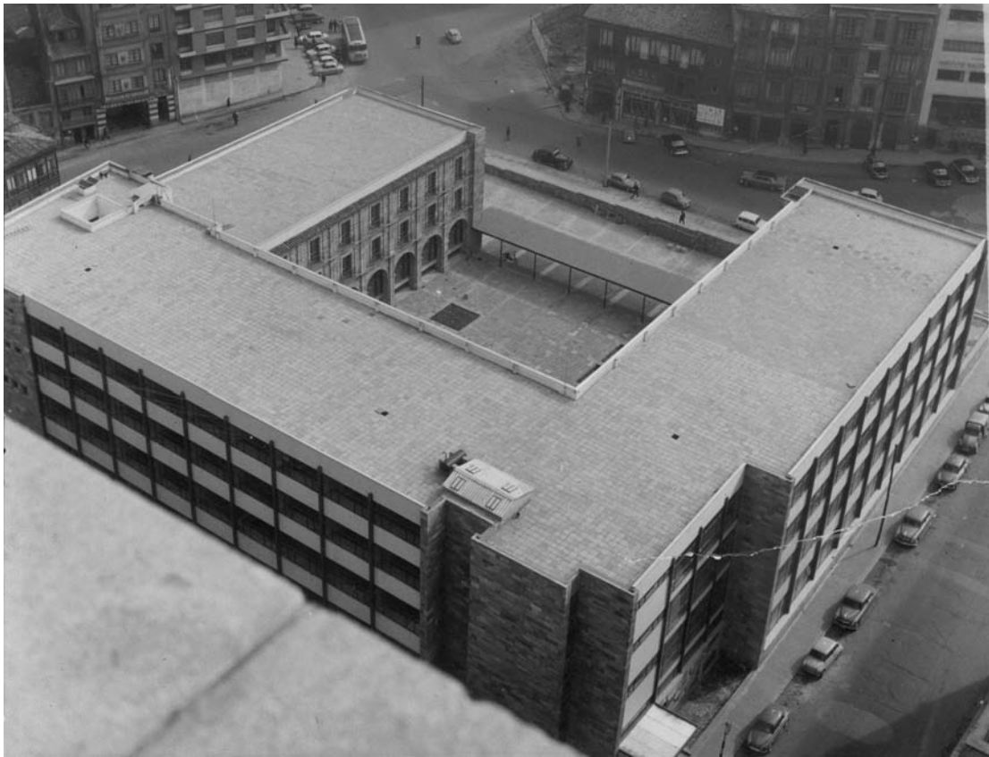
Fig. 11. La nueva Delegación de Hacienda en Oviedo, recién concluidas las obras. Fotografía publicada en el diario La Nueva España el 24 de marzo de 1966. (Archivo particular de la familia Álvarez Castela).
